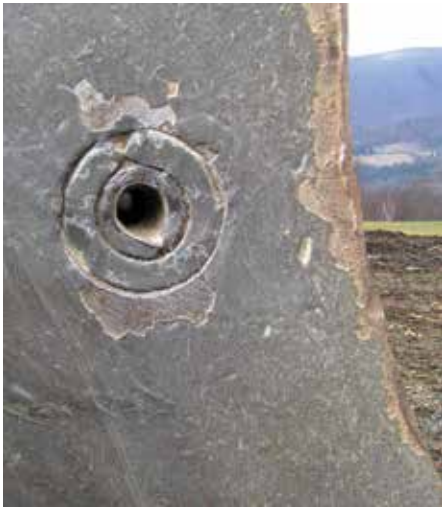
Verbundspannhülse: Schlitz um 180° versetzt angeordnet.
